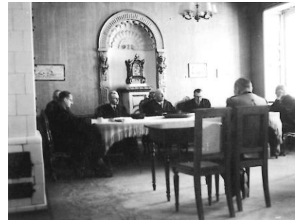
Gerichtsverhandlung im Regierungsgebäude
